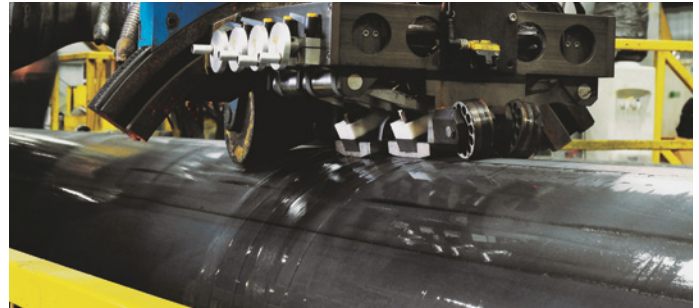
Figura 5: Inspección de la integridad de la soldadura del tubo con un aparato de ultrasonidos
